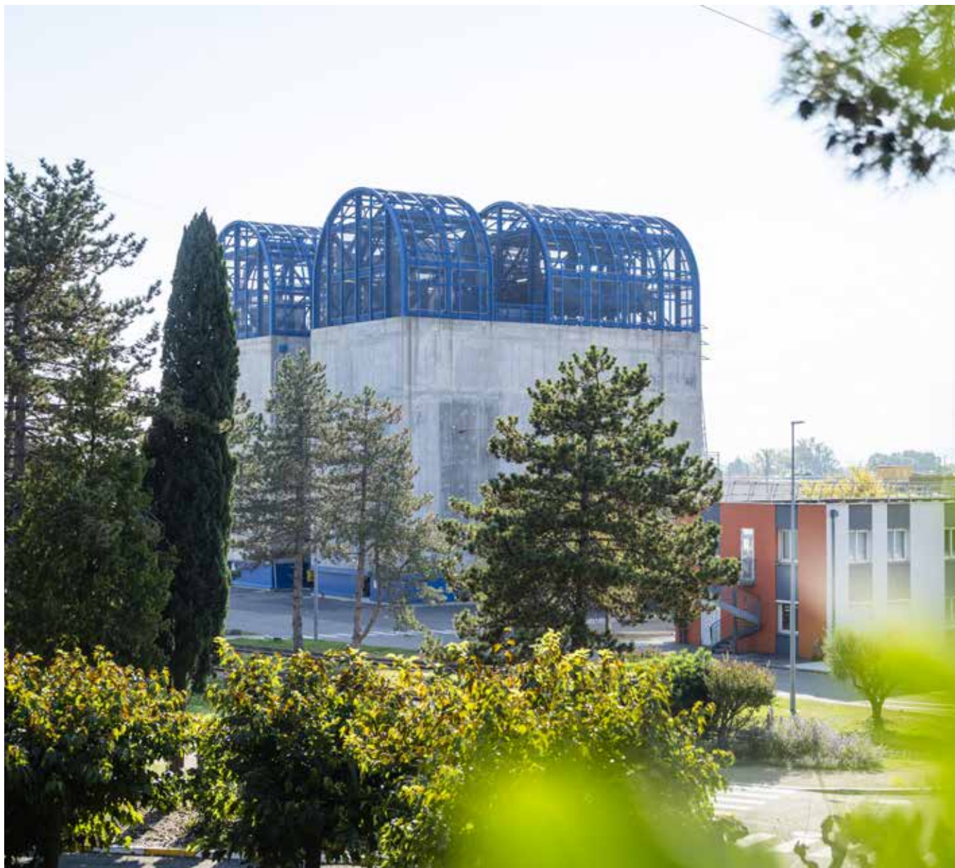
Diesels d'ultime secours
