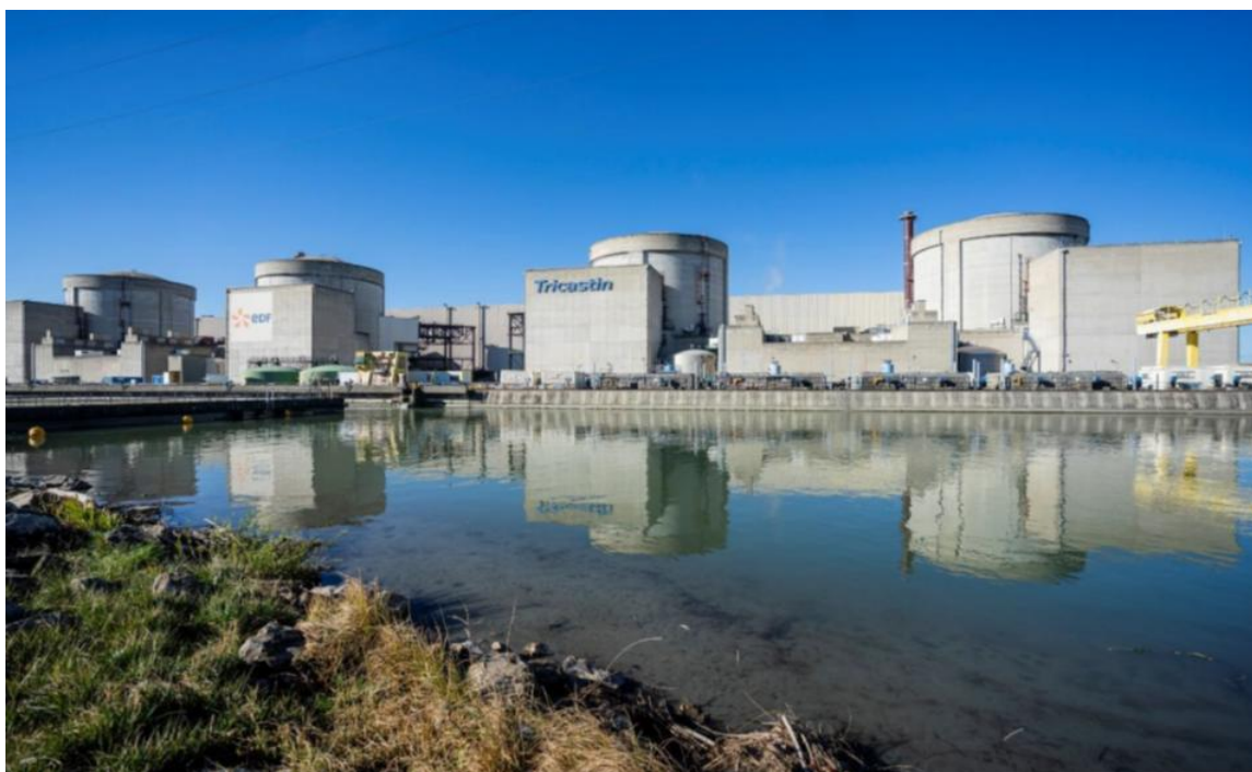
Figure 3: station de pompage du CNPE du TRICASTIN
