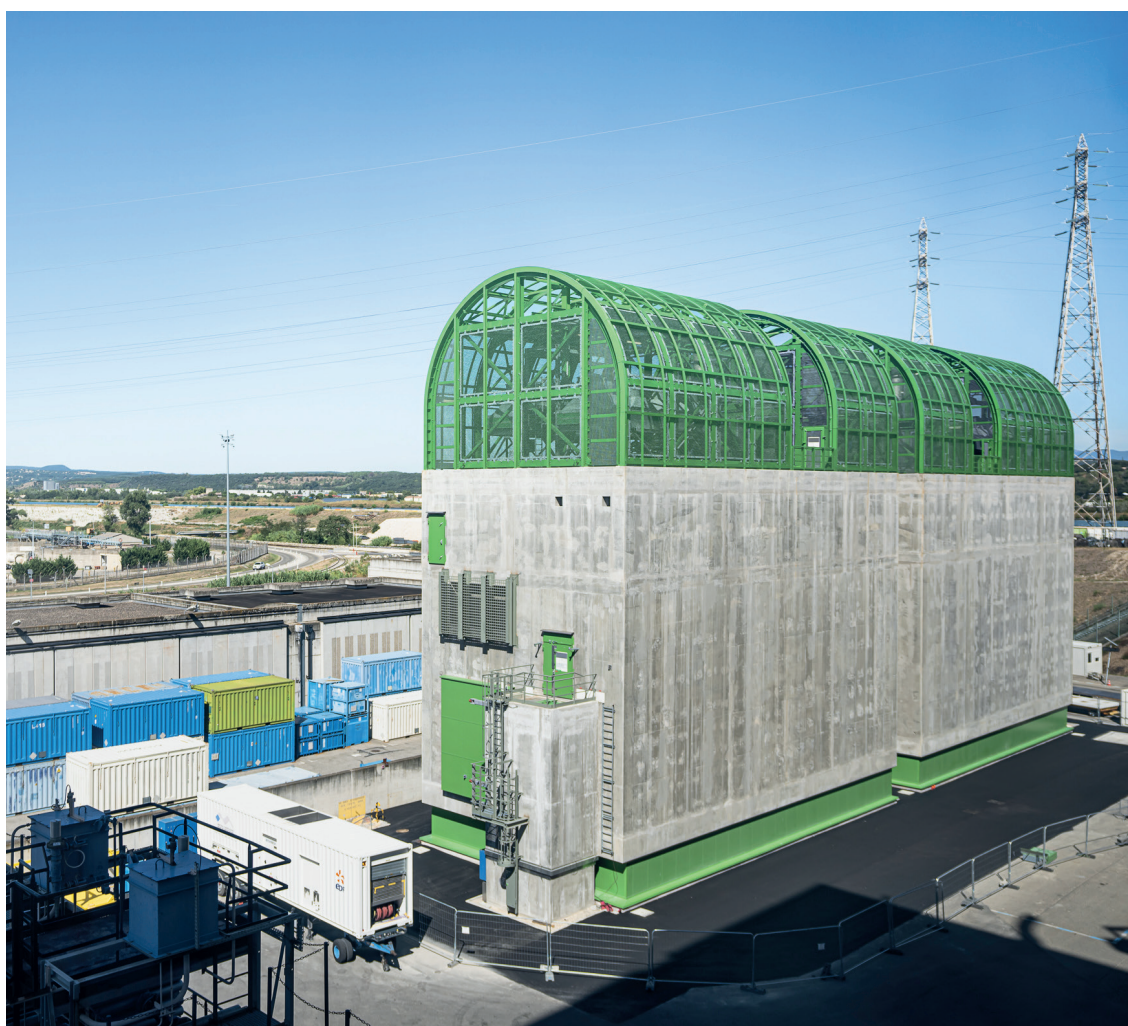
Diesels d'ultime secours ( DUS)
