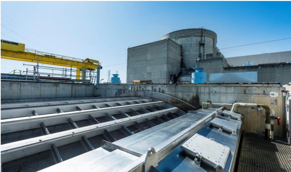
*Figure 4: les tambours filtrants du CNPE du Tricastin en station de pompage*
