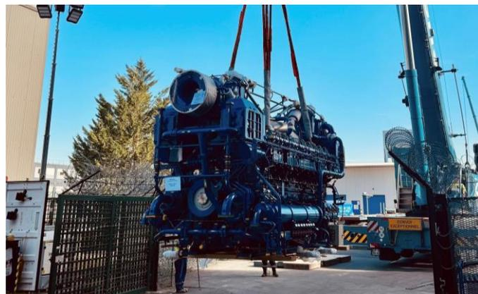
Le moteur diesel de secours assure de façon redondante l'alimentation électrique de certains systèmes de sûreté en cas de défaillance.
