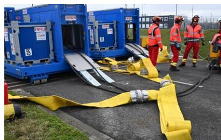
Installation d'une raquette flottante sur le canal d'aménée pour simuler la pose d'une alimentation de secours
