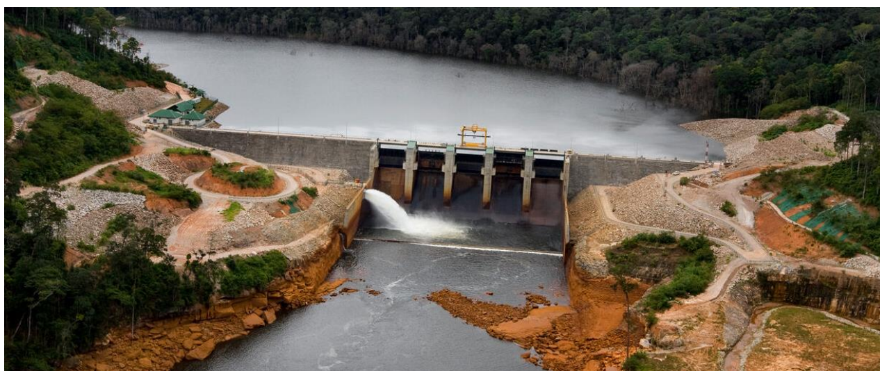
Centrale hydroélectrique de Nam Theun 2, Laos
