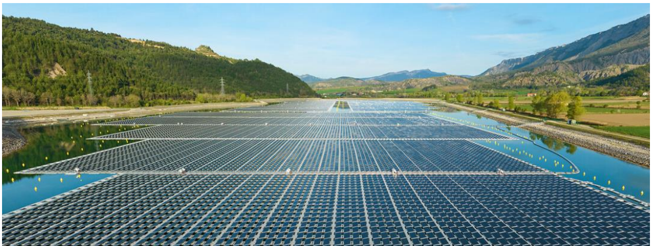
Centrale solaire flottante de Lazer, Provence Alpes Côte d'Azur, France
