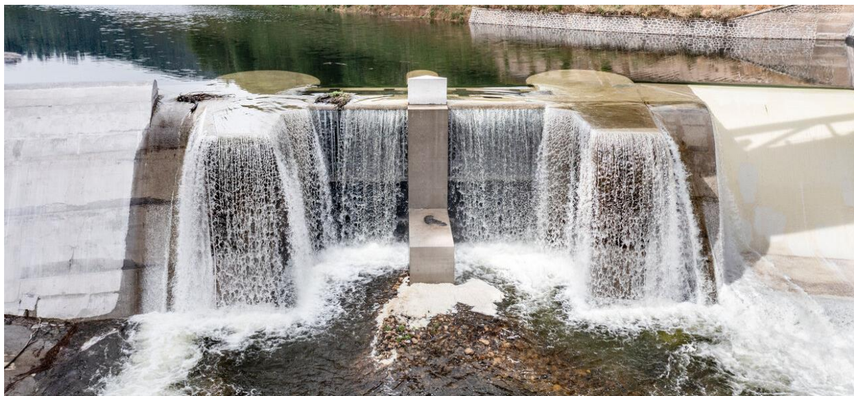
Barrage de Poutès, Haute Loire, France
