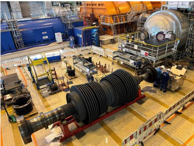
*Vue de la salle des machines avec le rotor haute pression entreposé pour une visite complète.*
