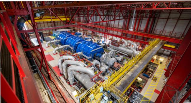
Une visite partielle est un arrêt programmé pour maintenance, qui fait partie du cycle normal d'exploitation de l'installation. Les réacteurs de 1 300 MWe, tels que ceux de Penly, s'arrêtent environ tous les 18 mois.
