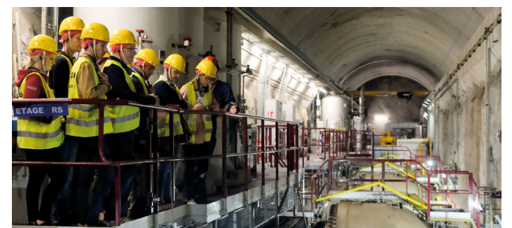
Journées de l'Industrie Électrique 2019, salle des machines de la STEP de Revin, Ardennes (08).
