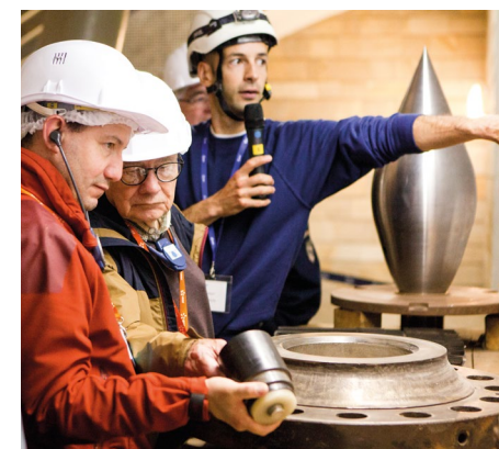
Journées de l'Industrie Électrique 2019, Centrale hydraulique de La Bâthie, Savoie (73).
