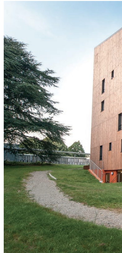
Le Grand Carcouët, programme innovant certifié BEPOS (bâtiment à énergie positive), grâce à une enveloppe thermiquement performante, à la mise en place de pompes à chaleur, à la récupération de calories sur les descentes d'eaux usées, ainsi qu'à des panneaux solaires sur la toiture.
